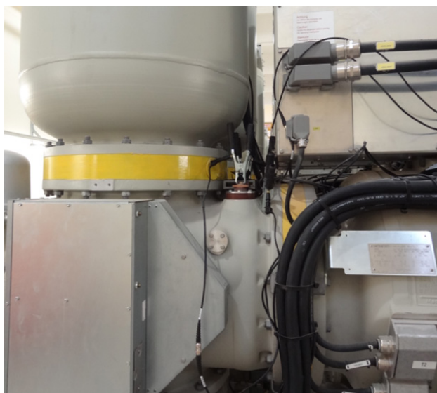
Una de las ferritas (C más) sobre el bus de cobre
